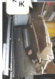
水を吸った天井材が落下
