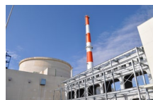
高速実験炉「常陽」
