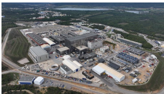
ITERサイトの建設状況
