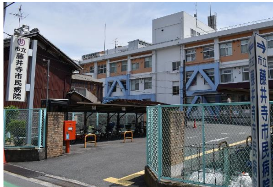
市立藤井寺市民病院 (大阪府藤井寺市)
