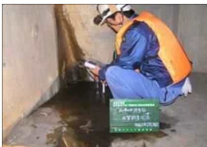
土木躯体点検
