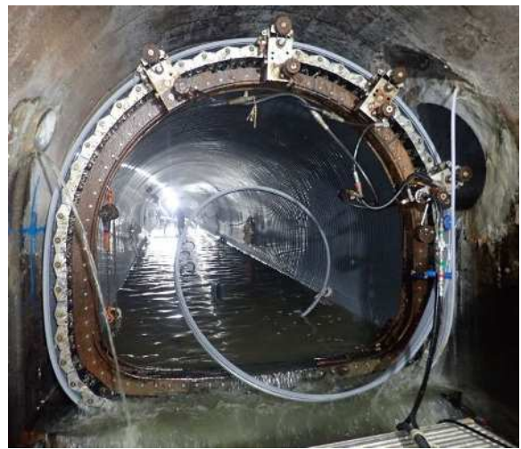
更生工法による幹線再構築
