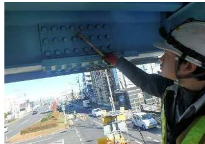
横断歩道橋点検
