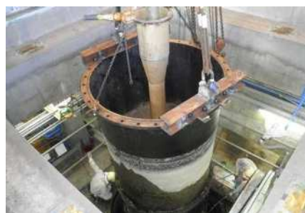
排水機場点検
