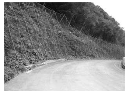
落石防止網工
