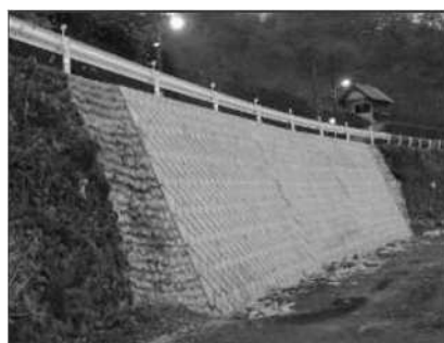
擁壁補強工（道路流失対策）
