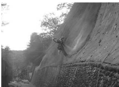
モルタル吹付工
