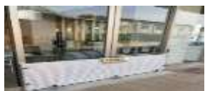
(止水板の設置)
