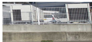
（電気設備の移設）
