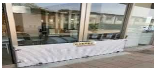
（止水板の設置）
