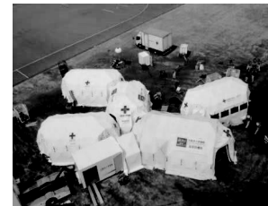
コンテナとテントを併用した仮設の診療施設
