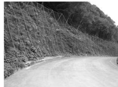
落石防止網工
