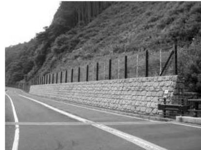
落石防護柵工
