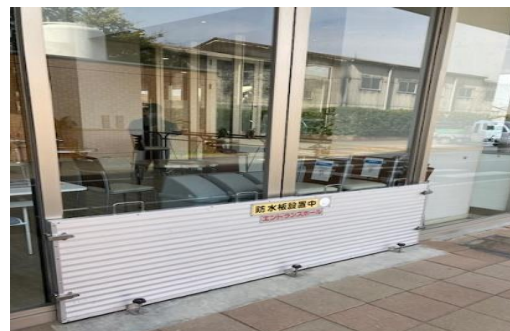
(止水板の設置)
