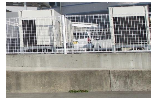
(電気設備の移設)
