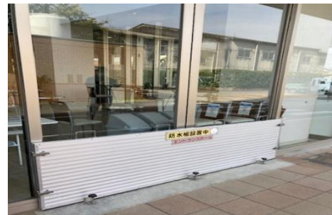
(止水板の設置)
