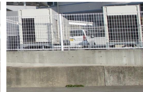
(電気設備の移設)
