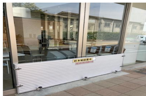
(止水板の設置)
