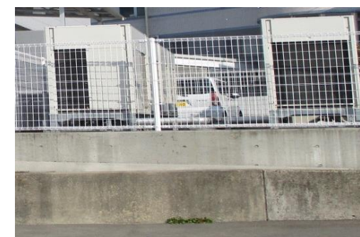
(電気設備の移設)
